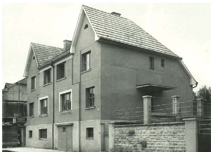
Dvořákova ulice, postaveno v roce 1932
